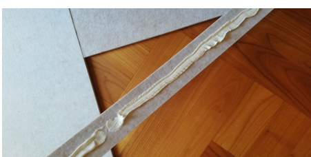
Falls Randleisten: Kleber anbringen und aufdrücken.
