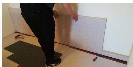
Feinjustierung: Fugen zueinander ausrichten
