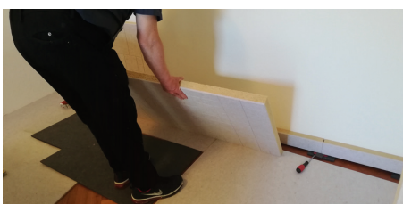
Platten an Wand anbringen und andrücken
