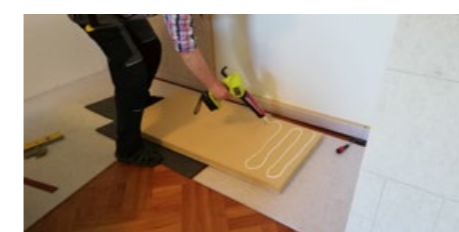
Kleber auftragen. Entweder Schlangenlinien wie Abbildung oder Punktuell, mind. 4 Punkt Kreise Durchmesser ca. 60mm mit gut Klebermasse.
