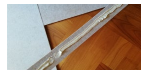
Falls Randleisten: Kleber anbringen und aufdrücken.
