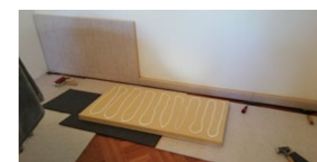
Kleber auftragen. Entweder Schlangenlinien wie Abbildung oder Punktuell, mind. 4 Punkt Kreise Durchmesser ca. 60mm mit gut Klebermasse.
