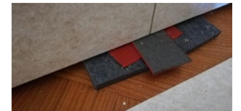
Sockel: Kleber anbringen, andrücken, im Wasser ausrichten und unterlegen, damit sich der Sockel nicht mehr verschiebt.
