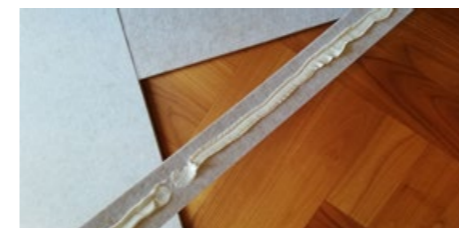
Falls Randleisten: Kleber anbringen und aufdrücken.
